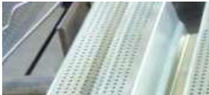
**Abbildung 1.1.2** – Trapezprofil mit quadratisch angeordneten Perforationen in den oberen Gurten
