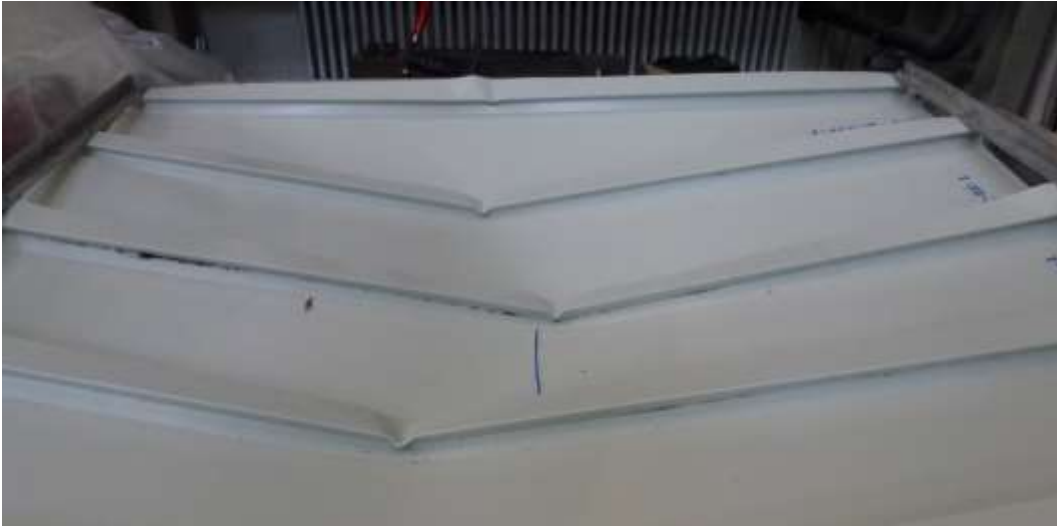
Figura 1.8 Collasso per instabilità locale del giunto per la prova di flessione eseguita su campata singola, sottoposta a carichi di aspirazione
